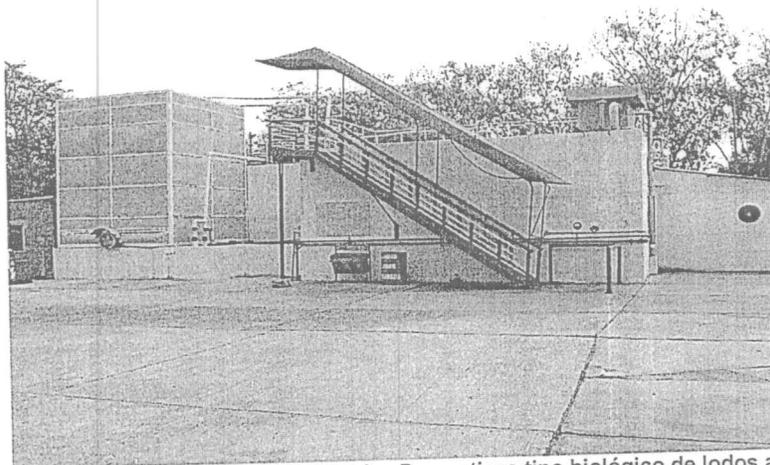
Fotografía No. 1 Planta de Tratamiento de Aguas Residuales Domesticas tipo biológico de lodos activados con aireación extendida y bioaumentación.
